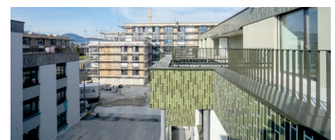
Die Wohnüberbauung Langrüti mit 120 Wohnungen in Jona.
